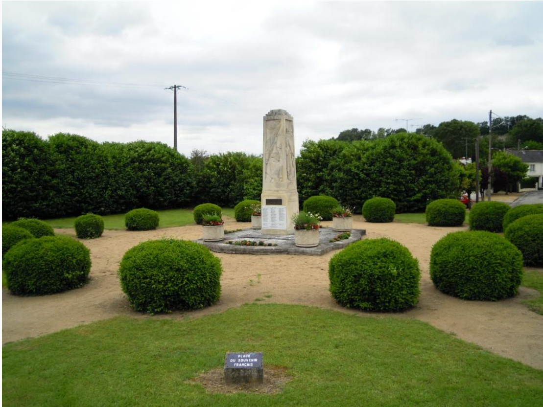
Vue d'ensemble, depuis le nord-est, en 2010.
