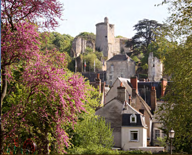
Les espaces verts aèrent la trame urbaine du centre
