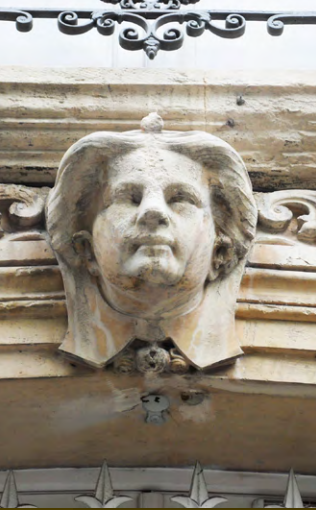
Détail d'une façade du XIX e siècle, avenue Eugène Brisson
