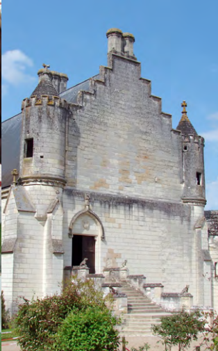
Le logis royal construit en 1377 a accueilli les rois de France de Charles V à François I er
