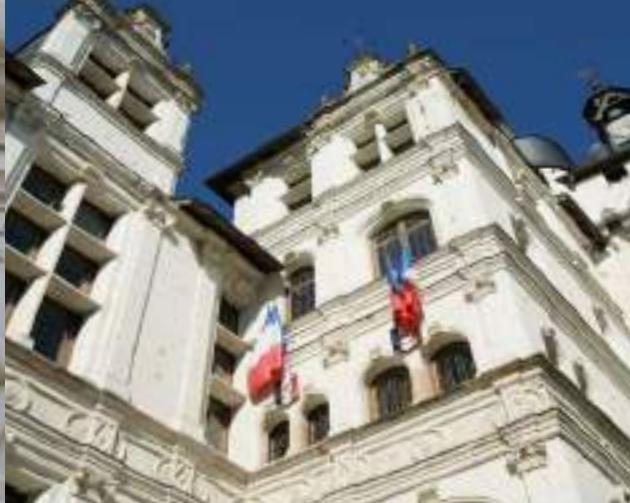
Hôtel de Ville : une façade quelque peu remaniée lors des restaurations du début du XX e siècle
