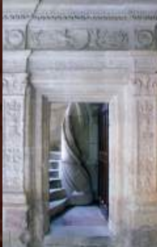
Cloître de la Psalette, porte desservant l'escalier en vis à l'angle des ailes nord et est
