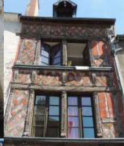
Cette façade, située au 14 rue Sainte-Catherine, propose une déclinaison d'un décor renaissant sur du pan de bois
