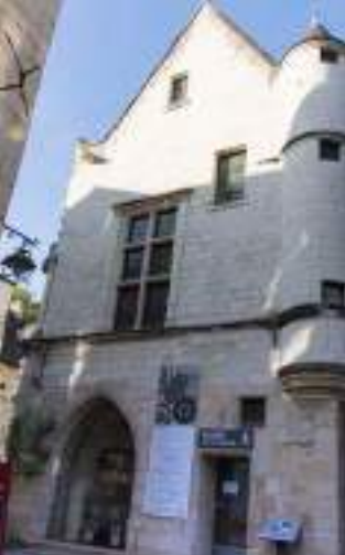
Maison des États généraux, façade sur rue
