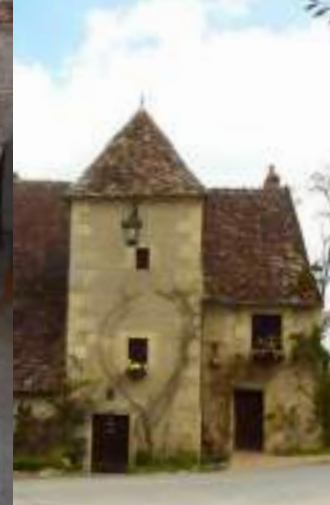
Maison des Mariniers en pierre calcaire d'Apremont
